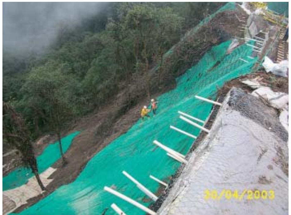
Aufwändig und zwecklos: Die Sicherung der Ölpipeline auf den Berrücken des Regenwaldes
