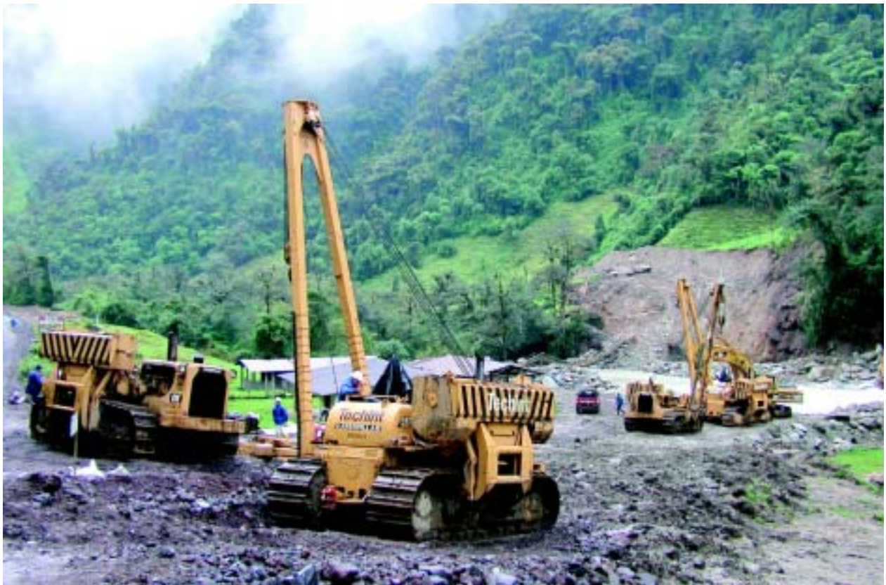
Im Yasuni-Nationalpark wird schweres Gerät eingesetzt um die Pipeline zu verlegen
