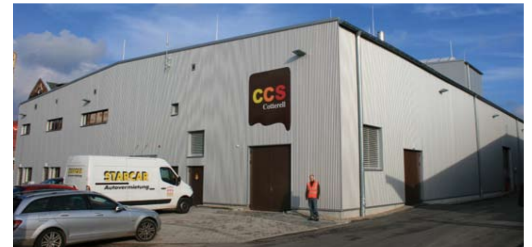
Die neue Halle befindet sich vis à vis des Stammsitzes im Ellerholzdamm
