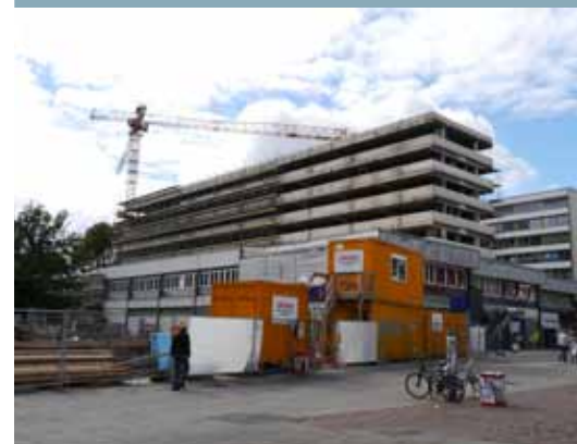
Bauarbeiten am Büro- und Geschäftsgebäude Schillerstraße 44
