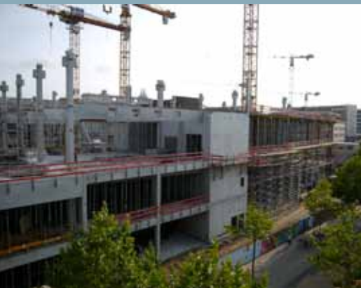
Blick auf die IKEA-Baustelle aus der Großen Bergstraße
