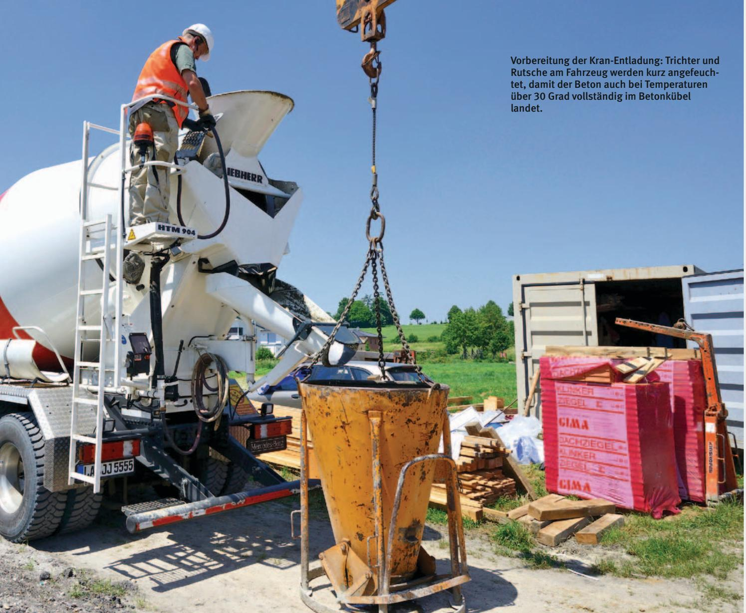
Vorbereitung der Kran-Entladung: Trichter und Rutsche am Fahrzeug werden kurz angefeuchtet, damit der Beton auch bei Temperaturen über 30 Grad vollständig im Betonkübel landet.
