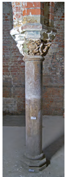
Freigelegte Säule im Keller des Hauses
