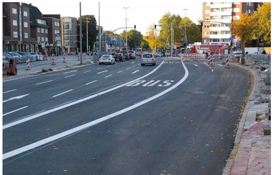
Siemersplatz: Die Busbeschleunigung nützt besonders dem Autoverkehr. Wer als Radfahrer geradeaus fahren will, muss Rechtsabbiegespuren queren und an einer zweiten Ampel warten.
