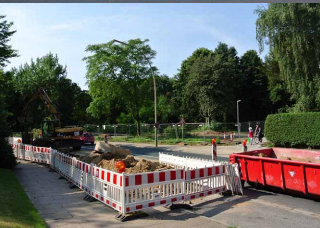
Baustelle am Hammer Steindamm Nähe U-Bahn
