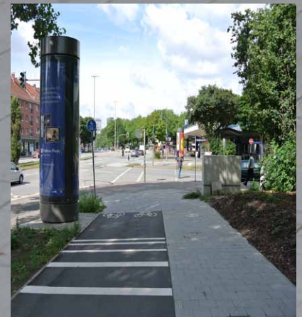
Ende der Ausbaustrecke U-Bahn Burgstraße
