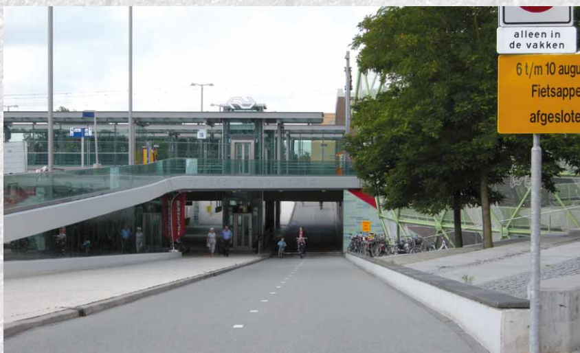
In den Niederlanden wird eine gleichmäßige Geschwindigkeit erreicht, indem Unterführungen für den Radverkehr gebaut werden.
