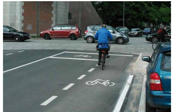
Jetzt gibt es am Rübenkamp diesen aufgeweiteten Radfahrstreifen.
