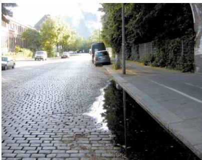
Vor dem Umbau: Radweg und Fahrbahn sind unkomfortabel.
