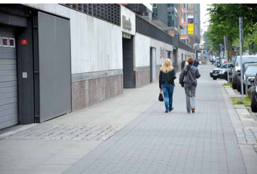
Zweirichtungsradweg mit den üblichen Hindernissen und Gefahren.
