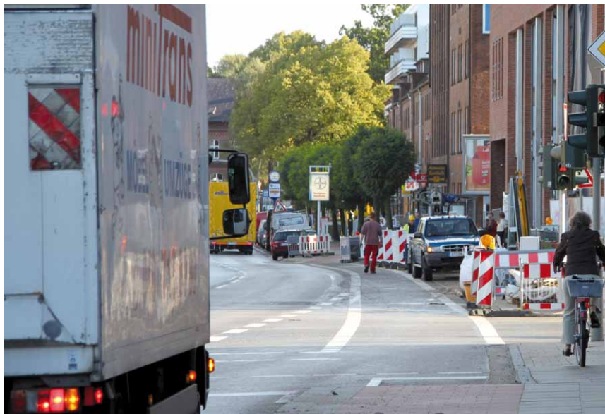
Hier entsteht die neue Bushaltestelle am Einkaufszentrum Herthastraße. Wer's noch kennt: Da gab es früher einen fiesen Radweg über die Zufahrt von Max Bahr mit der anschließenden Null-Sicht-Ausfahrt hinter dem Gebäude und der bei Dunkelheit unsichtbaren Führung direkt auf einen Kantstein zu. Das war die pure Zumutung.
