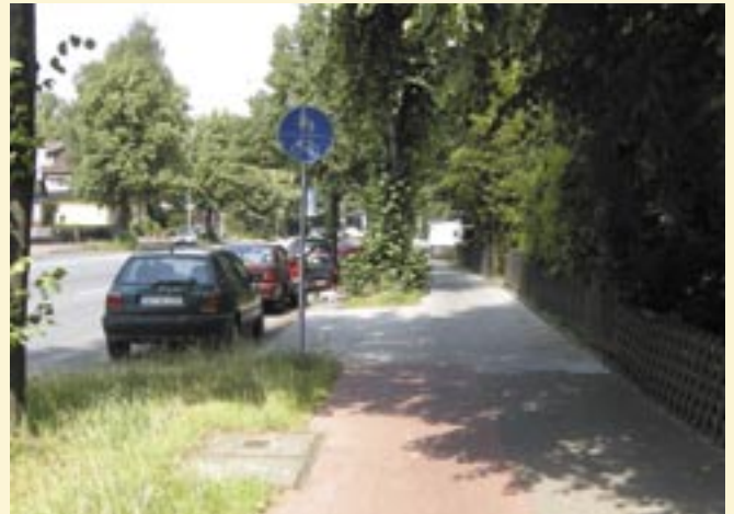
... Problemstellen bleiben bei reiner Oberflächensanierung aber bestehen und beeinträchtigen Sicherheit und Komfort.
