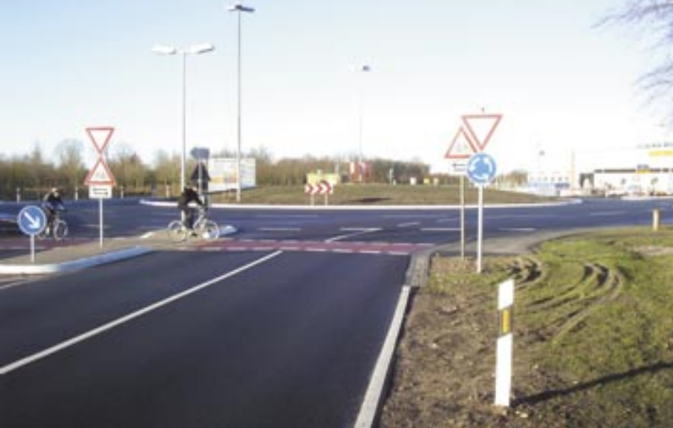
Der berühmte Megakreisel bei Pinneberg. Radfahrer sollen im Zweirichtungsverkehr über die Furt der Landstraße Schenefeld-Elmshorn über drei Fahrstreifen fahren. Seit dem Bau ist der Kreis ein Unfallschwerpunkt – auch mit Radfahrereteiligung.
