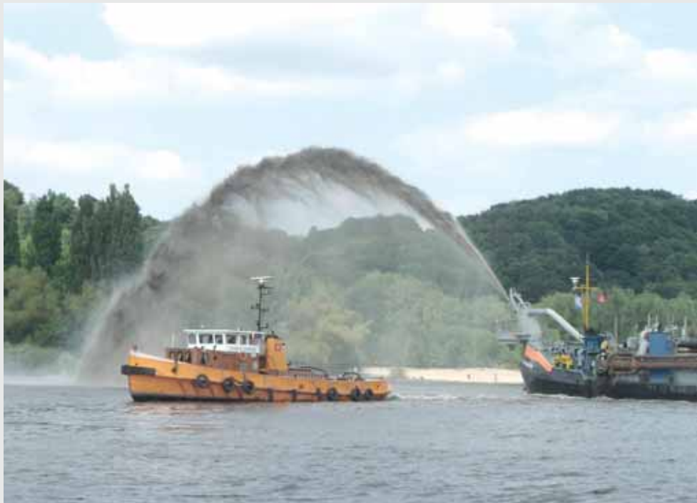
Sandvorspülung mit Laderaumsaugbagger
