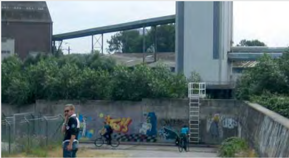
Mauerplattform am Reiherstieg
