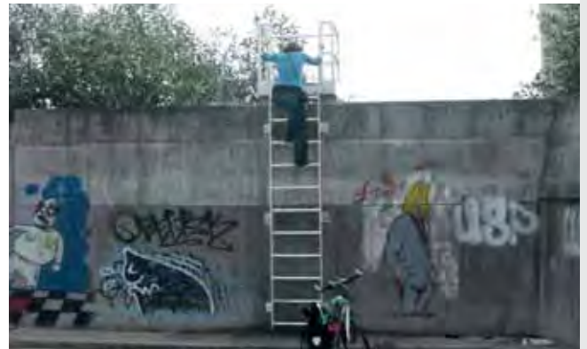
Erklimmen der Mauerplattform
