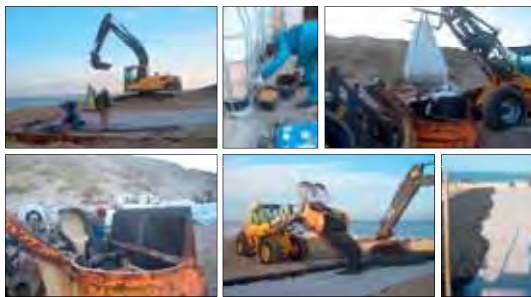
Abbildung 2: Erbauung der Deckwerkerweiterung (Bilder: Treuel 2009)
