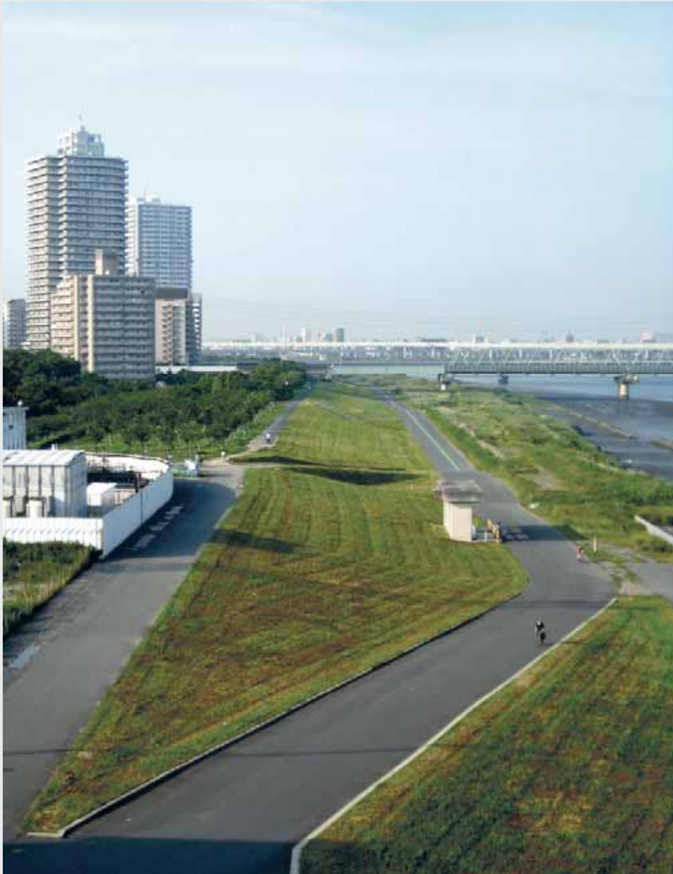
Edogawa Super Levee
