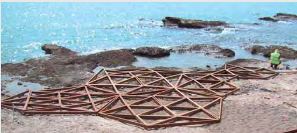
Unterbau der Küstenplattformen
