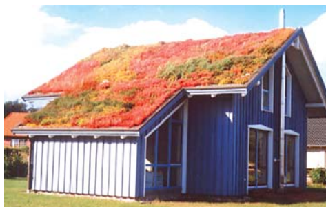
Abbildung 5: Gründächer (extensive Nutzung) als Flach- und Schrägdächer
