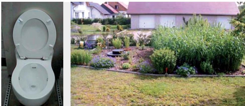
Abbildung 6: Vakuuntoilette (links) und Bodenfilter (rechts) ( www.flintenbreite.de , www.zebrafilter.de )
