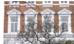
Behutsame Sanierung des Hauses
