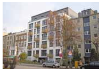
Graumannsweg 42 nach Umbau und Aufstockung
