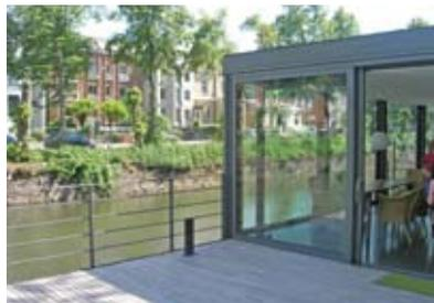
verwendet und das Materialspektrum klein gehalten. Außen Cortenstahl und Glas, sämtliche Geländer sind aus Stahl wie bei einem Schiff die Reeling. Für die Fußböden im Außenbereich wurde in Deutschland angebautes Hartholz gewählt, das nicht oberflächenbehandelt ist, sondern von Wind und Wetter patiniert wird und eine leicht silbrige Verfärbung erfährt.
