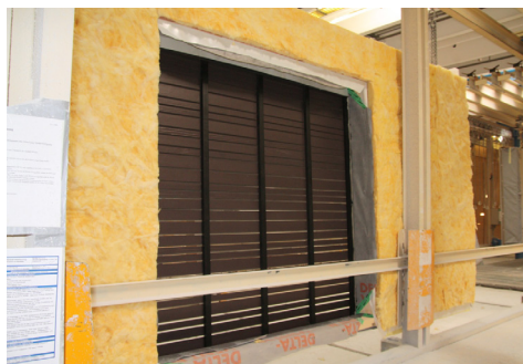
Abb. 19: Außenwand-Schalung und Dämmung
