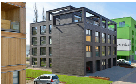
Abb. 2: Ansicht Nordseite, Mai 2013
