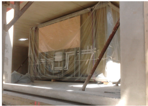
Abb. 24: Installation der Fertigbau-Badzelle
