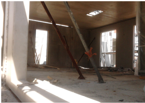
Abb. 23: Fertigteilinstallation Sommer 2012 so auf ein System reduziert: eine vollflächige Betonkernaktivierung anstelle einer Kombination mit dem Frischluft-Heizsystem.
