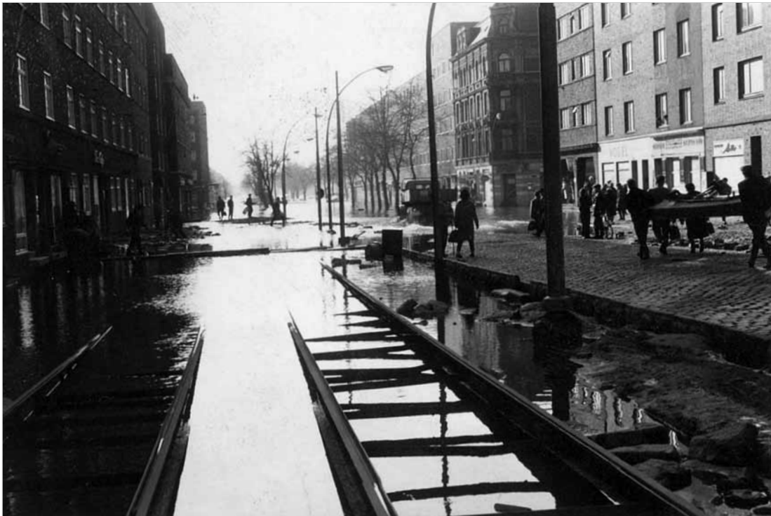
Die Wassermassen haben die Straßenbahnschienen in der Georg-Wilhelm-Straße unter-spült. (©MEW)
