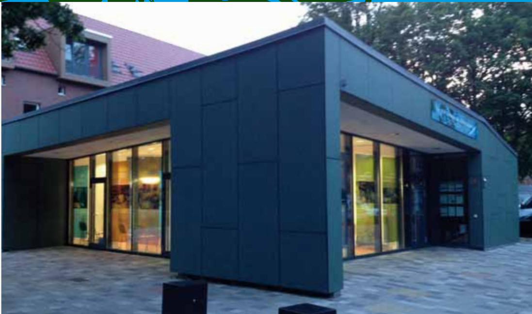
Außenansicht des Ausstellungspavillons bei Innenbeleuchtung. (©Niehuis)
