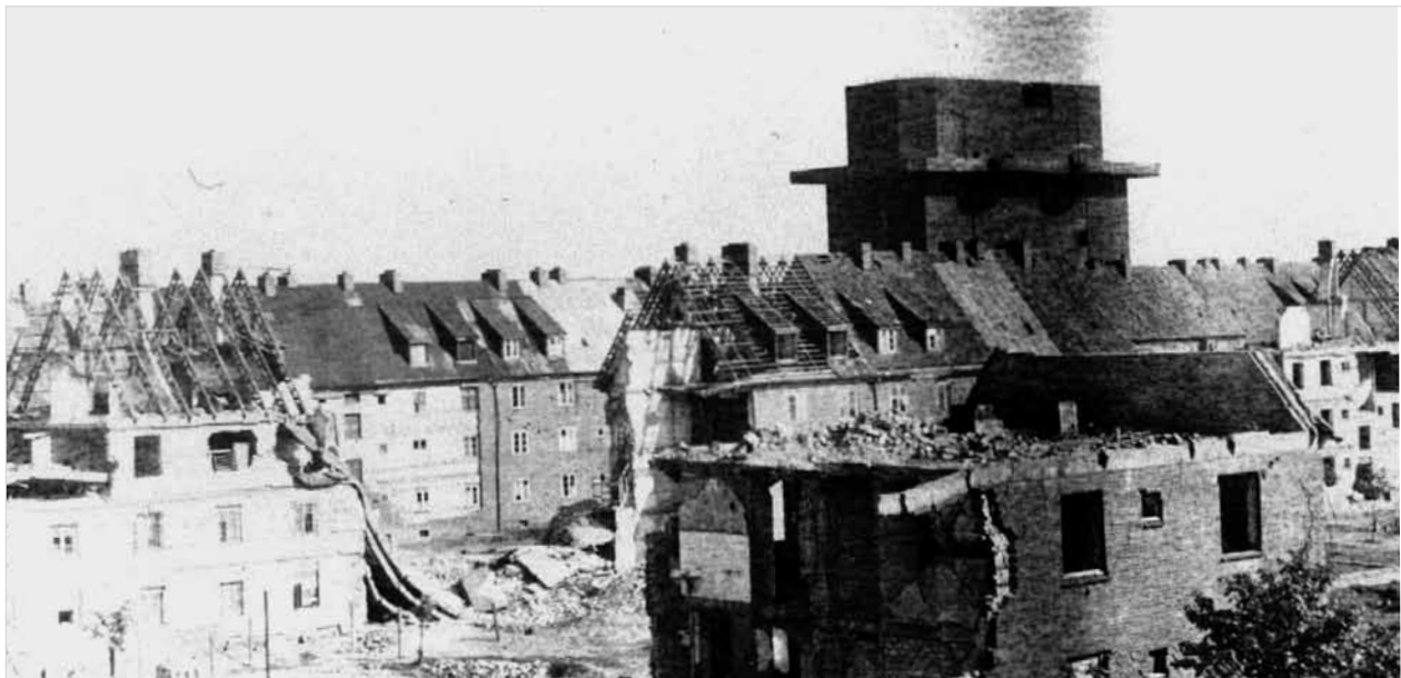
Im Zweiten Weltkrieg haben Bombardierungen viele Wohnhäuser zerstört, im Hintergrund der Leitturm des Flakbunkers am Rotenhäuser Feld. (©MEW)
