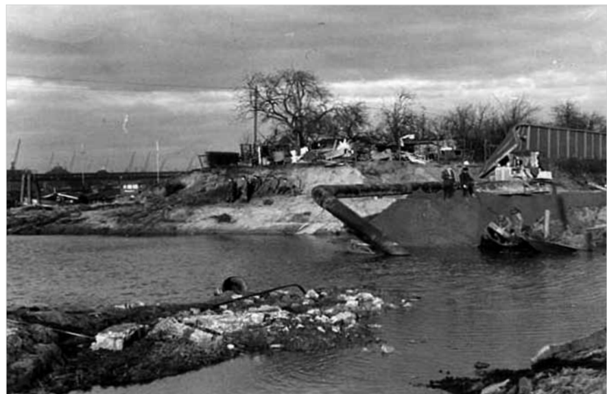
Der Deich am Spreehafen ist gebrochen. (©MEW)
