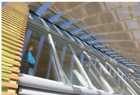
Abb. 21: Übergang von GFK-Boards zur Textilmembran
