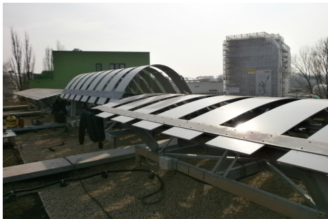
Abb. 23: Aufstellung der GFK-Boards
