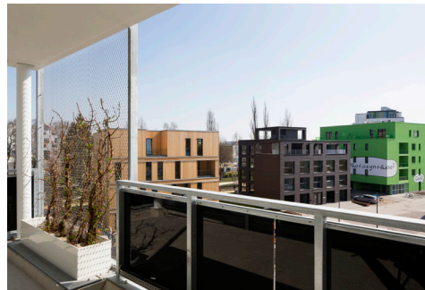
Abb. 22: Blick vom Balkon im 1. OG, Mai 2013
