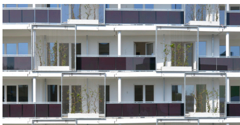
Abb. 10: Dünnschicht Solarkollektoren
