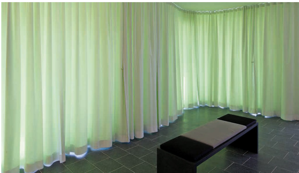
Abb. 9: PCM-Vorhänge im Erdgeschoss
