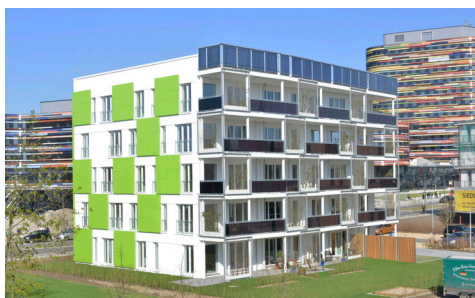
Abb. 2: Ansicht von Südwesten, Mai 2013
