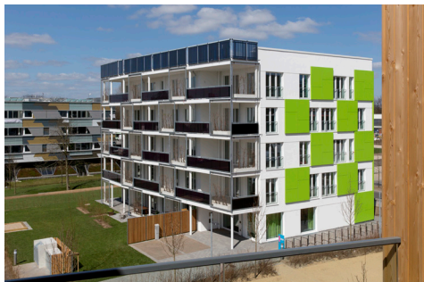
Abb. 1: Ansicht von Südosten, Juni 2013
