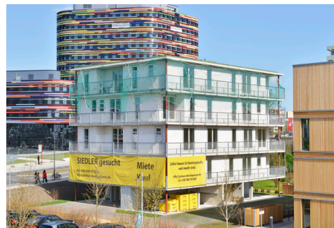
Abb. 23: Ansicht Südwesten, Mai 2013
