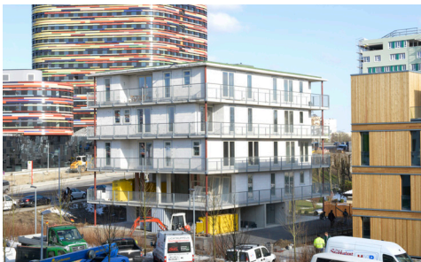
Abb. 1: Ansicht Südwestfassade, April 2013
