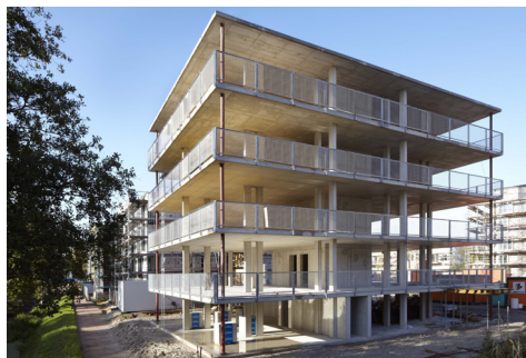
Abb. 18: Baustelle Grundbau, Sommer 2012
