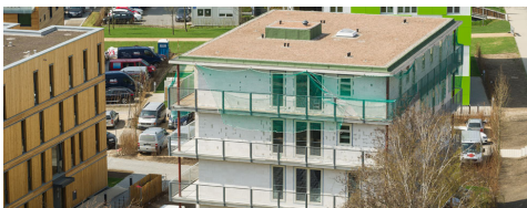
Abb. 2: Ansicht Ostseite, Mai 2013
