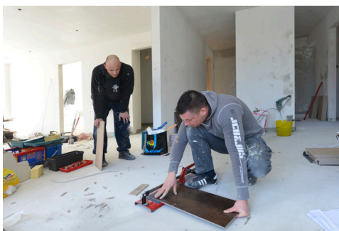
Abb. 21: Einweisung durch Vorführmeister
