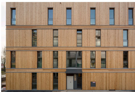
Abb. 17: Horizontale Bänder Nordfassade
