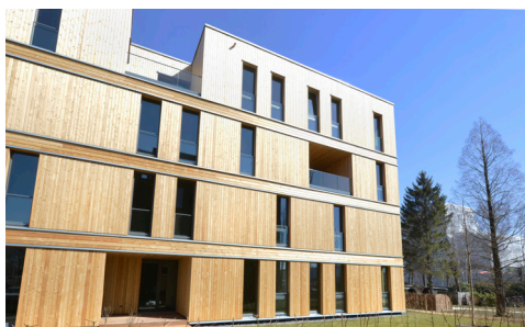
Abb. 2: Ansicht Ostfassade, April 2013
