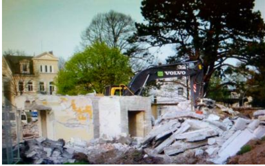
Abriss des Tiefbunkers beim Blankeneser Bahnhof Foto: U. Knoop-Troullier
