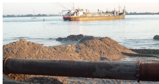
Einen Meter dick wird die Sandschicht aufgespült
