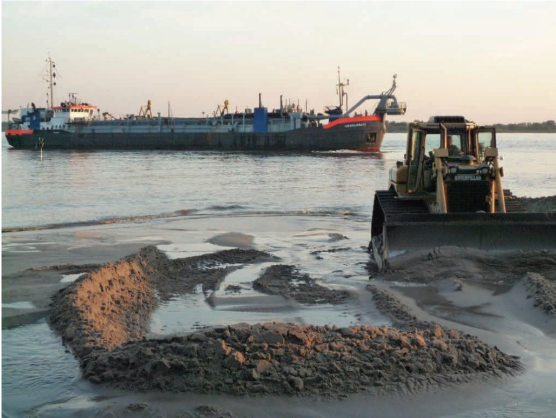
Der Hopperbagger spült das Sand-Wassergemisch mit einer Rohrleitung an das Ufer, wo eine Raupe alles verteilt
