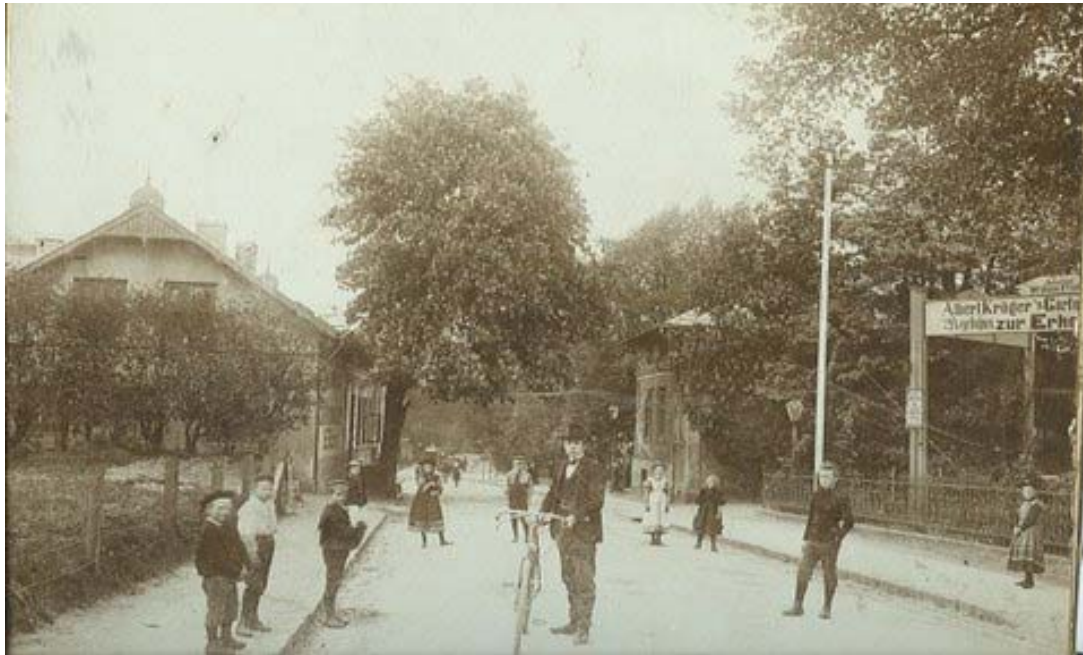
Im ehemaligen Haus der Osterschule an der Elbchaussee liegt die Kohlenhandlung Holst. Gegenüber das Gartenlokal Zur Erholung anno 1904, heute Hotel Baur's Park. Ganz im Hintergrund die Straßenbahn
