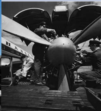
Wartungsarbeiten an einem der vier Curtiss Wright Turbo-Compound-Motoren einer Lockheed L 1049 G „Super Constellation“ 1958.
