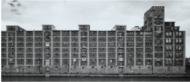
Das architektonisch bedeutende Zentrallager am Hovekanal soll, wie viele andere Bauten des GEG-Ensembles auf der Peute, abgerissen werden.
