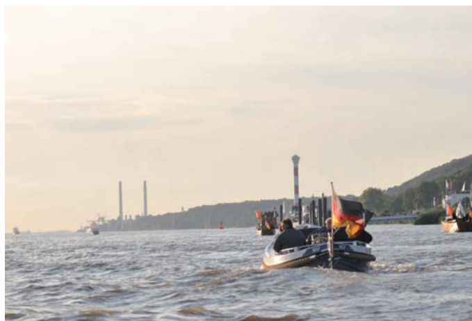
Keine Leuchttürme sondern die Schornsteine des Heizkraftwerkes Wedel
