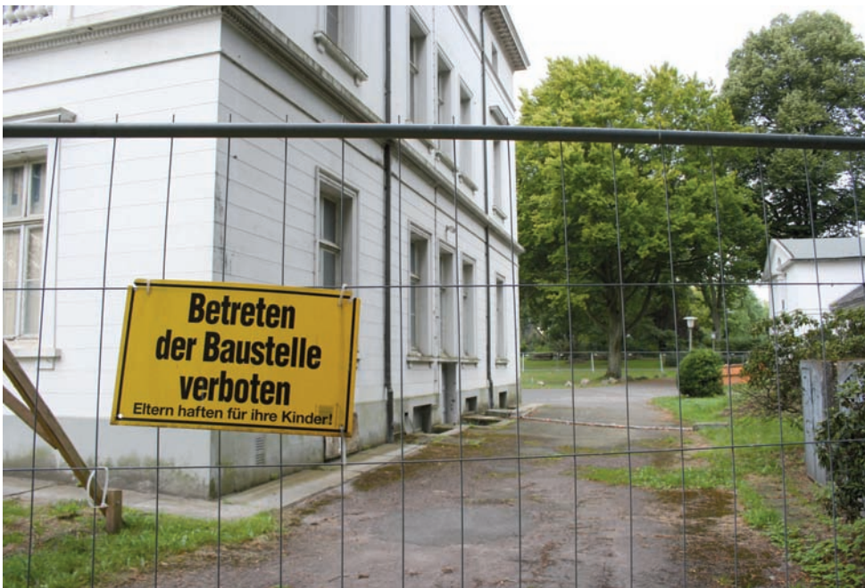
Die Baustelle Katharinenhof beschäftigt Anwohner, Verwaltung und Bürgerverein nun schon seit vielen Jahren
