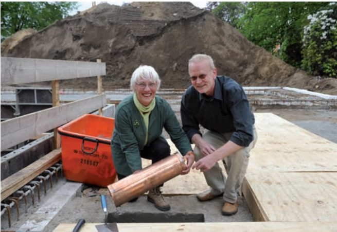
Elke Krause und Architekt Niklas Schindel vom Vorstand der Hermann und Lilly Schilling Stiftung legen den Grundstein für das neue Stift
