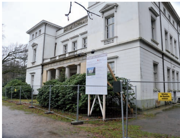
Bauzaun am Katharinenhof im Baurspark
