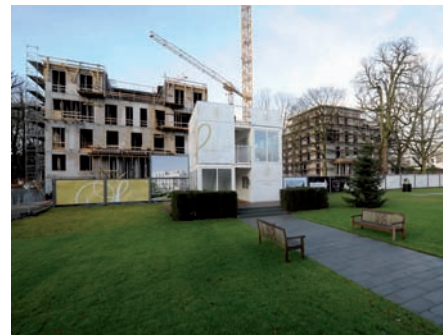
Im März dieses Jahres feiern die Sophienterrassen Richtfest.
