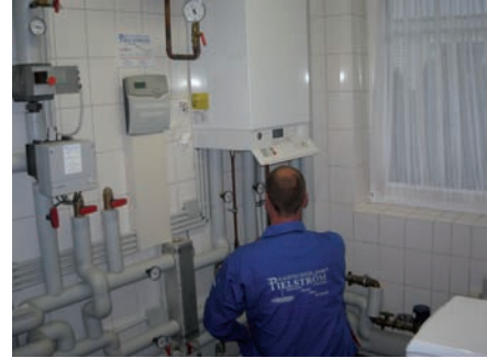
Ein Pielström-Mitarbeiter arbeitet an einer Heizungsanlage
