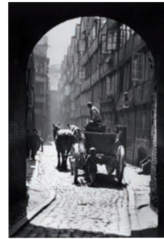
Geschichte: Fuhrwerk im Gängeviertel
