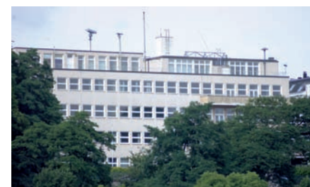
Parkanlage der ehemaligen Lehrstätte soll Neubauten weichen
