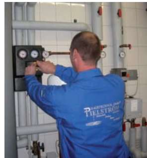
Ein Pielström-Mitarbeiter beim Heizungswarten
