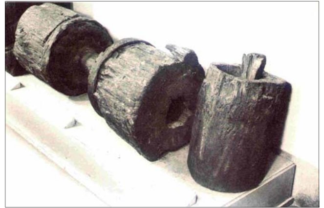
Teilstücke der verbrannten Wasserleitung, die aus ausgehöhlten Baumstämmen mit Verbindungen aus Blei hergestellt waren. Quelle: Meng
