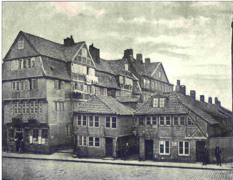
Die ehemaligen „Soldatenwohnungen“ in der Spitalerstraße, Ecke Kurze Mühren wurden von Feuerwehrleuten bewohnt.
