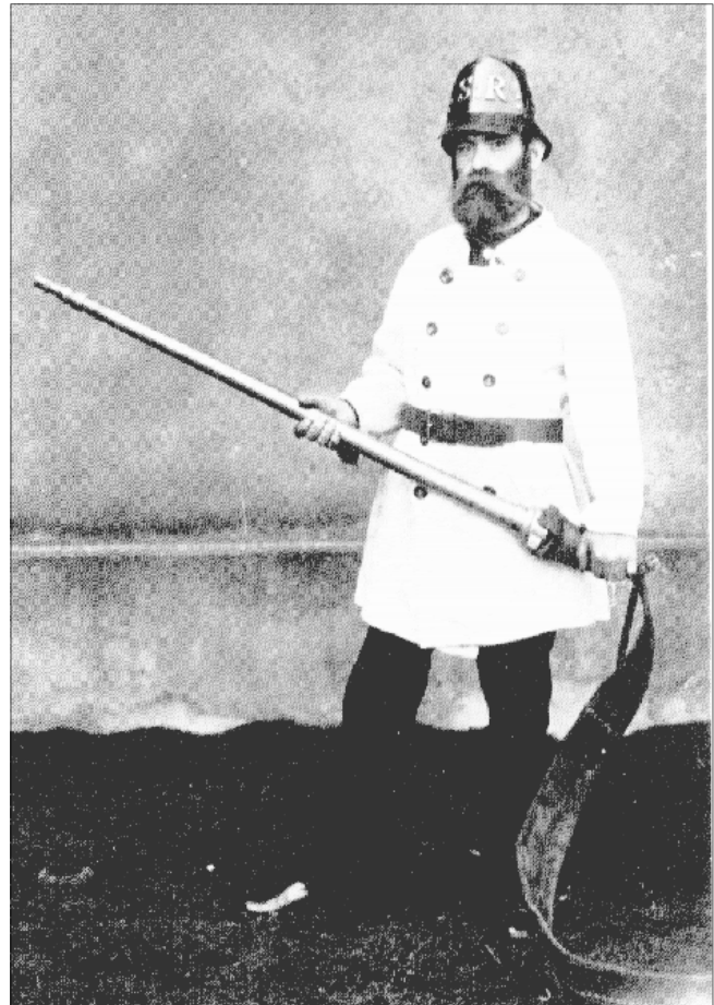
Rohrführer der Schiffsspritzen
