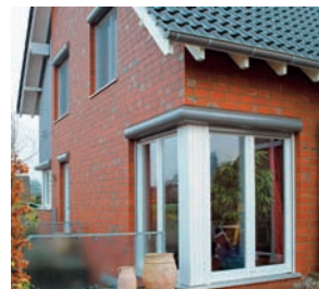
Fenster können für gravierende Wärmeverluste verantwortlich sein
