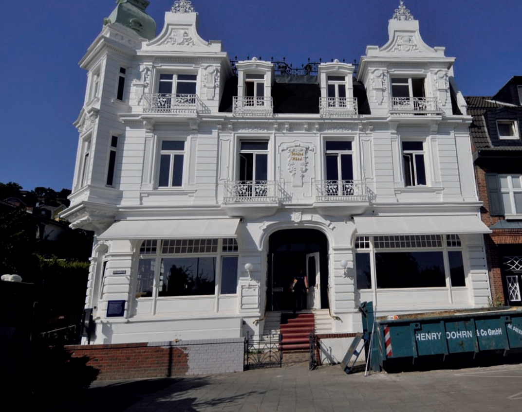
Das Strandhotel Blankenese wurde rundum renoviert und saniert. Am 15. September öffnen sich wieder die Türen
