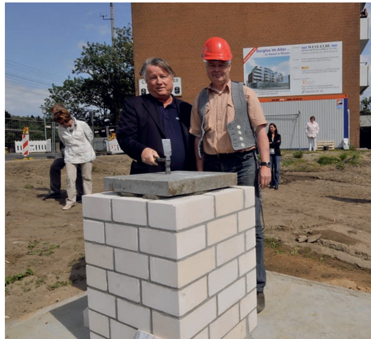
West-Elbe Geschäftsführer Heinrich Linder und Polier Hasenpusch legten den Grundstein für die Seniorenwohnanlage „Am Rissener Bahnhof“
