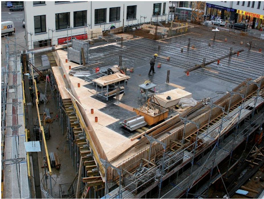
Bahnhof Blankenese: Bauarbeiter gönnen sich auch im Winter keine Pause und ziehen das letzte Haus hoch
