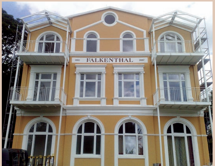
Das ehemalige Hotel zum Falkenthal: Hier entstehen barrierefreie Wohnungen für ältere Menschen
