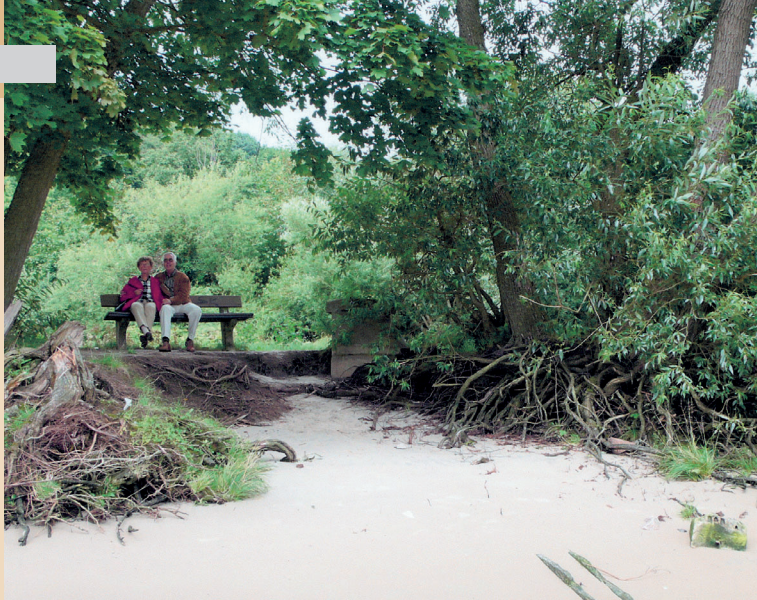
Das Wittenbergener Ufer bereitet seit Jahren Kopfzerbrechen
