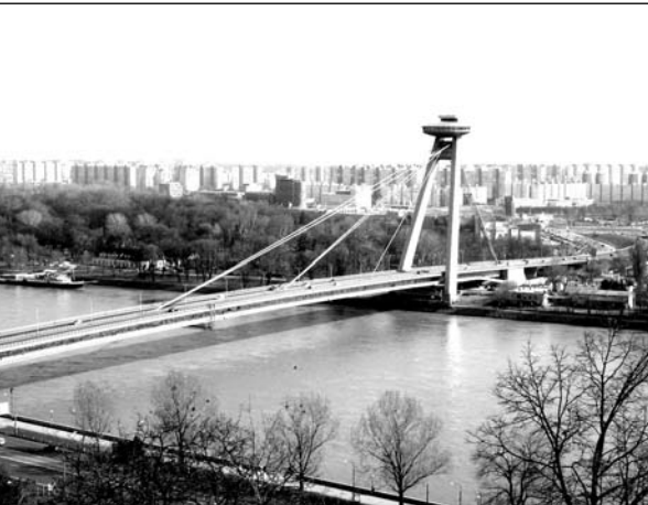
Die Donaubrücke verbindet Bratislava und Petržalka
