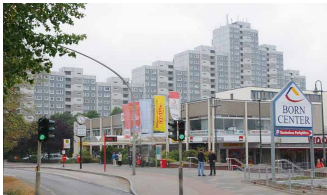
Die Förderung von Wohnungsmodernisierungen und Instandsetzungen wird auch in den 1990er-Jahren fortgesetzt
