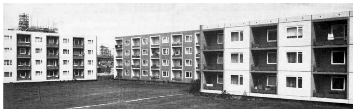
Die Montagebauweise mit Fertigteilen gewährleistet eine kürzere Bauzeit
