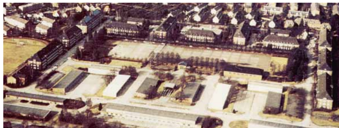
Auf dem Gelände der Boehn-Kaserne entsteht ein modernes Wohnquartier
