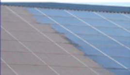
Durch Verschmutzungen verringert sich die Energieausbeute Ihrer Anlage um bis zu 32 %. Die Kosten für die Reinigung werden durch die Leistungssteigerung amortisiert. Reinigung erfolgt mit deionisiertem Wasser und einer weichen Bürste. Keine Kalkablagerungen, kein Verkratzen der Solar-Platten.
