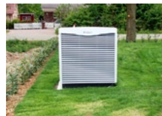
Die Außeneinheit der Wärmepumpenanlage im Garten.
