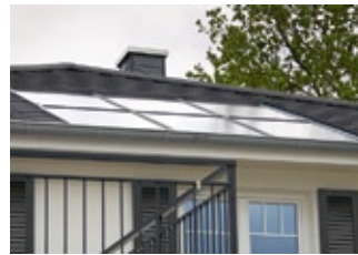
Auf dem Dach wurden Dünnschicht-Innendach-Photovoltaik-Module verbaut.
