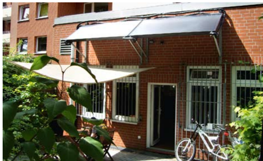
Solarkollektoren an der rückwärtigen Fassade.
