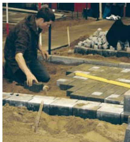
Konzentration beim Pflastern.
