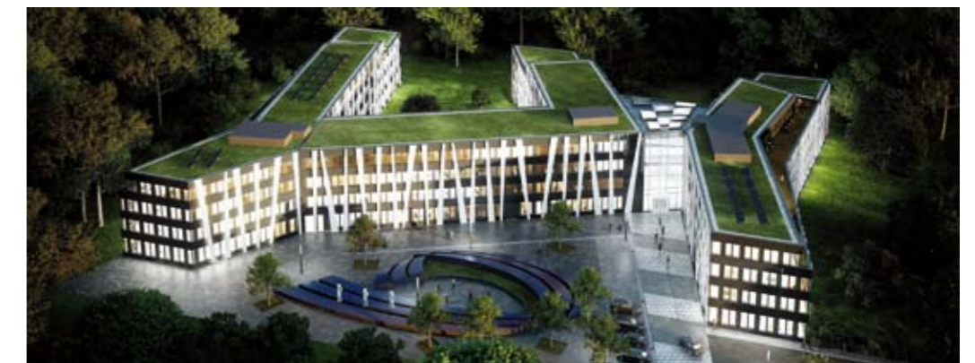
Die neue Nordex-Zentrale in Hamburg-Ochsenzoll
