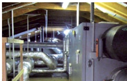
Lüftungsgerät EXHAUSTO VEX 250 mit Wärmerückgewinnung
