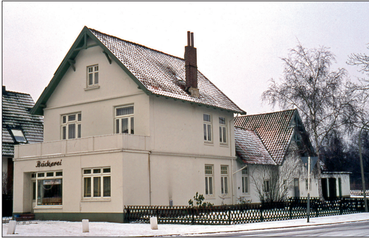
Abbildung 19: Hof 8, ehemals Katenstelle, zuletzt Bäckerei Kock, Foto 1976
