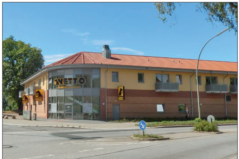
Abbildung 27: An der Stelle des Bauernhauses Westphal entstand 2009 ein Wohngebäude mit Einkaufsmarkt, Foto 2013
