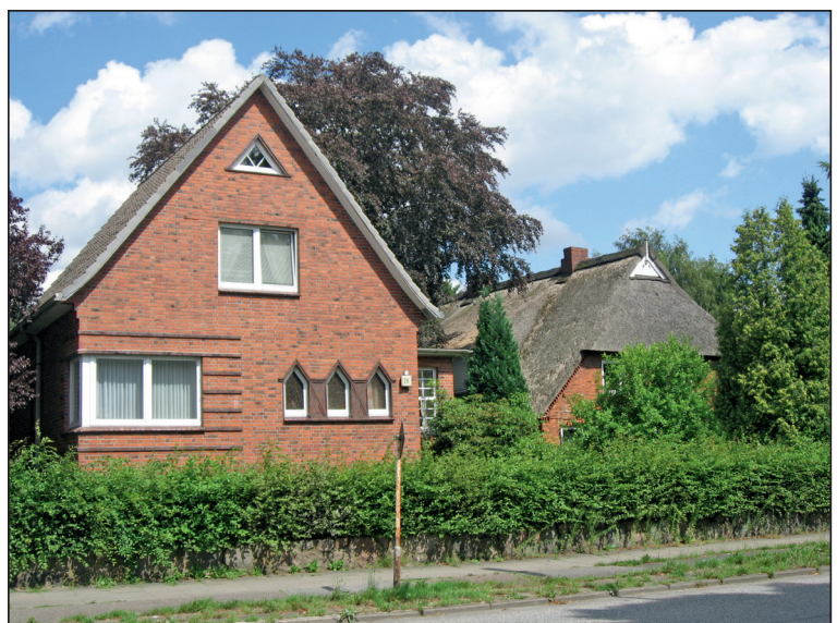
Abbildung 4: Ensemble von ehemals Heinrich Schierhorn in der Saseler Straße, vor Brandlegung und Abriss
