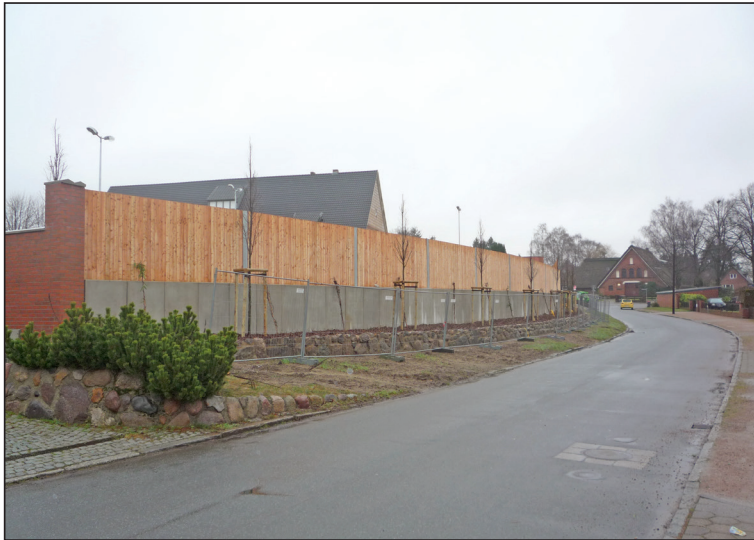
Abbildung 11: Die Mauer am Dassauweg. Der Bewuchs ist noch spärlich.
