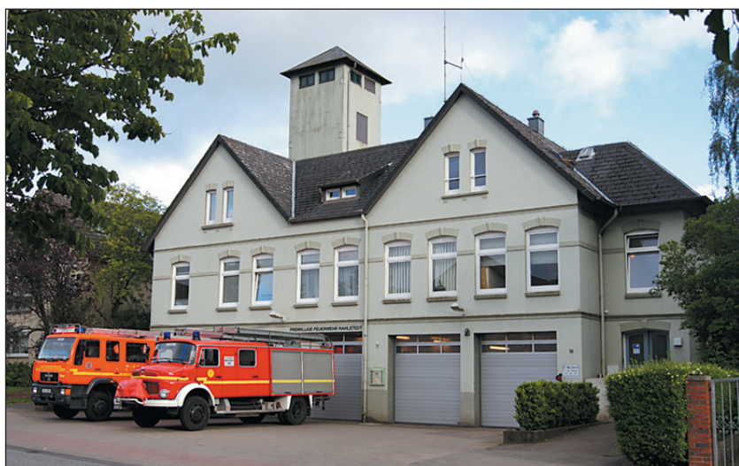
Abbildung 14: Wenige Feuerwehrhäuser in Hamburg haben noch einen Schlauchturm. Einsatzbereit stehen davor die Löschgruppenfahrzeuge LF 16/12nB und LF 16/TS. Foto 2012
