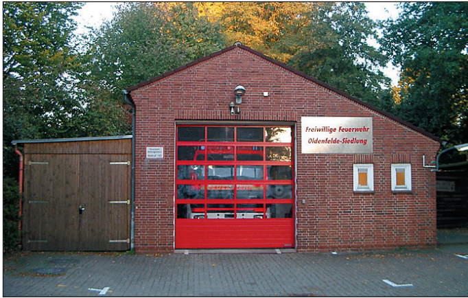
Abbildung 34: Unser Feuerwehrhaus in der Bekassinenu
