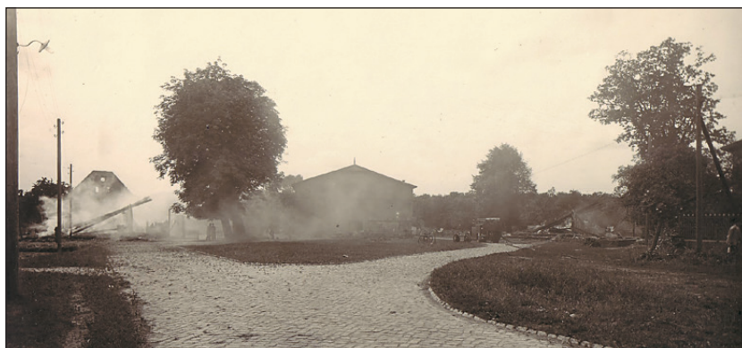
Abbildung 9: Beim Angriff vom 26./27. Juli 1942 wurden die Bauernhäuser Bergholz und Doose vollständig zerstört.
