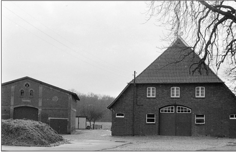
Abbildung 12: Hof Bergholz nach dem Wiederaufbau
