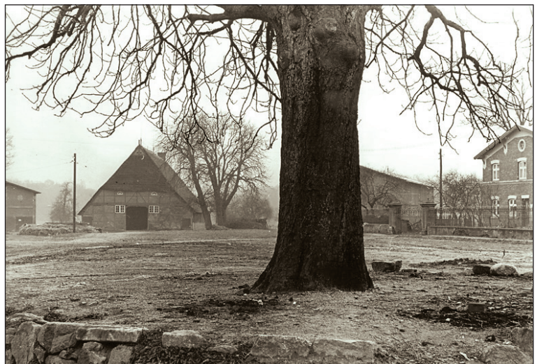
Abbildung 11: Hof Bergholz, Scheune Doose und Nebenhaus Remstedt, 1937
