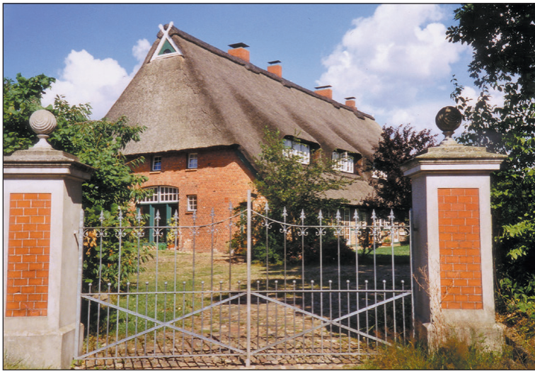
Abbildung 6: Ehemaliger Hof Hinsch nach Umgestaltung für Wohnzwecke, 1997
