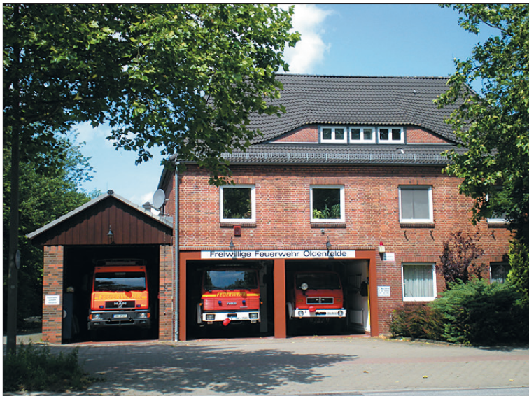
Abbildung 16: Feuerwehrhaus in der Bargteheider Straße, Foto 2012
